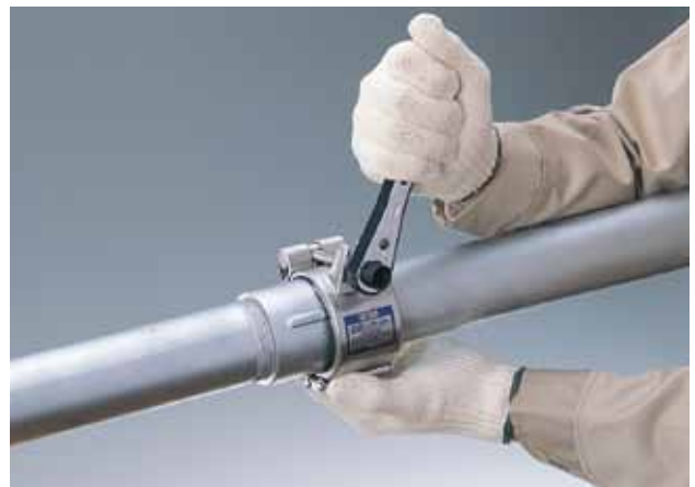
⑤ ボルトをラチェットレンチで締め付けます。
