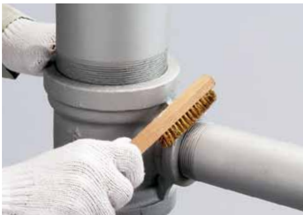
① ネジ部のサビや汚れを除去します。
