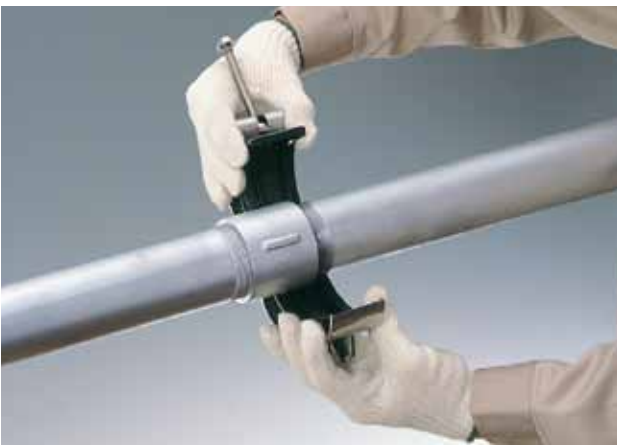
② 本体を漏えい箇所巻きつけます。
